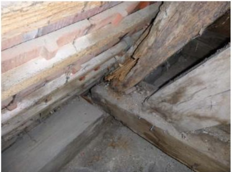
Bild 52 Sparren/Deckenbalken 13 Bund 4 Südseite
