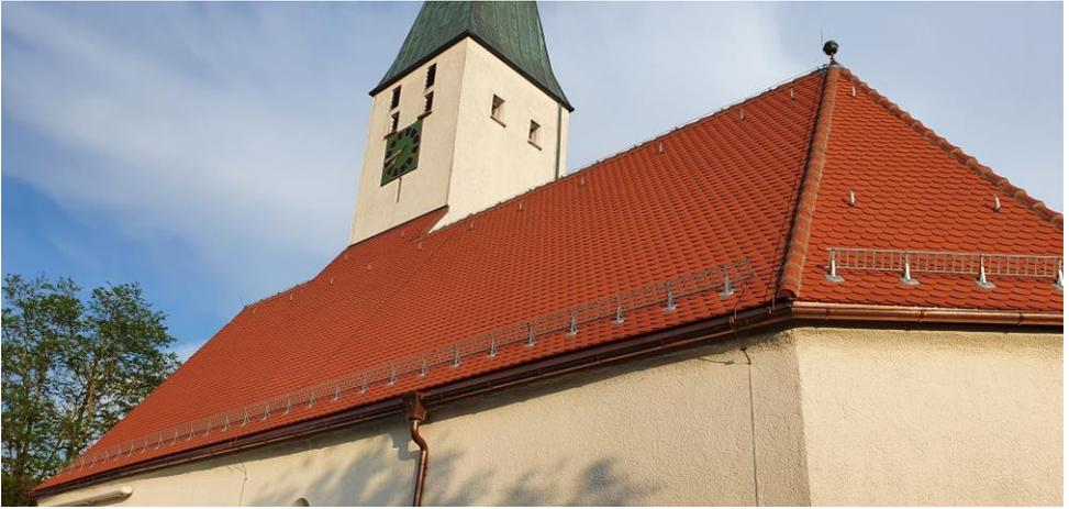
Unser „Dachschaden“ ist nun, nach mehrmonatiger Restaurierung behoben. Viele Balken im Dachstuhl waren in sehr schlechtem Zustand und mussten ausgetauscht werden. Von einigen alten Balken konnte das Alter bestimmt werden. Der älteste gefundene Balken war aus dem Jahre 1341, andere Balken wurden im Winter des Jahres 1427/1428 gefällt. Die Dachkonstruktion Richtung Aussegnungshalle wurde um ca. 15cm angehoben, um ein Abrutschen zu verhindern. Auch die Deckenbalken auf
